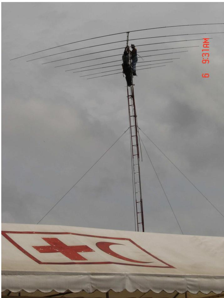
**Foto 2: instalación de antena HF en Panamá para comunicaciones de emergencia (fonía y PACTOR) con la zona del Caribe durante la temporada de huracanes**
